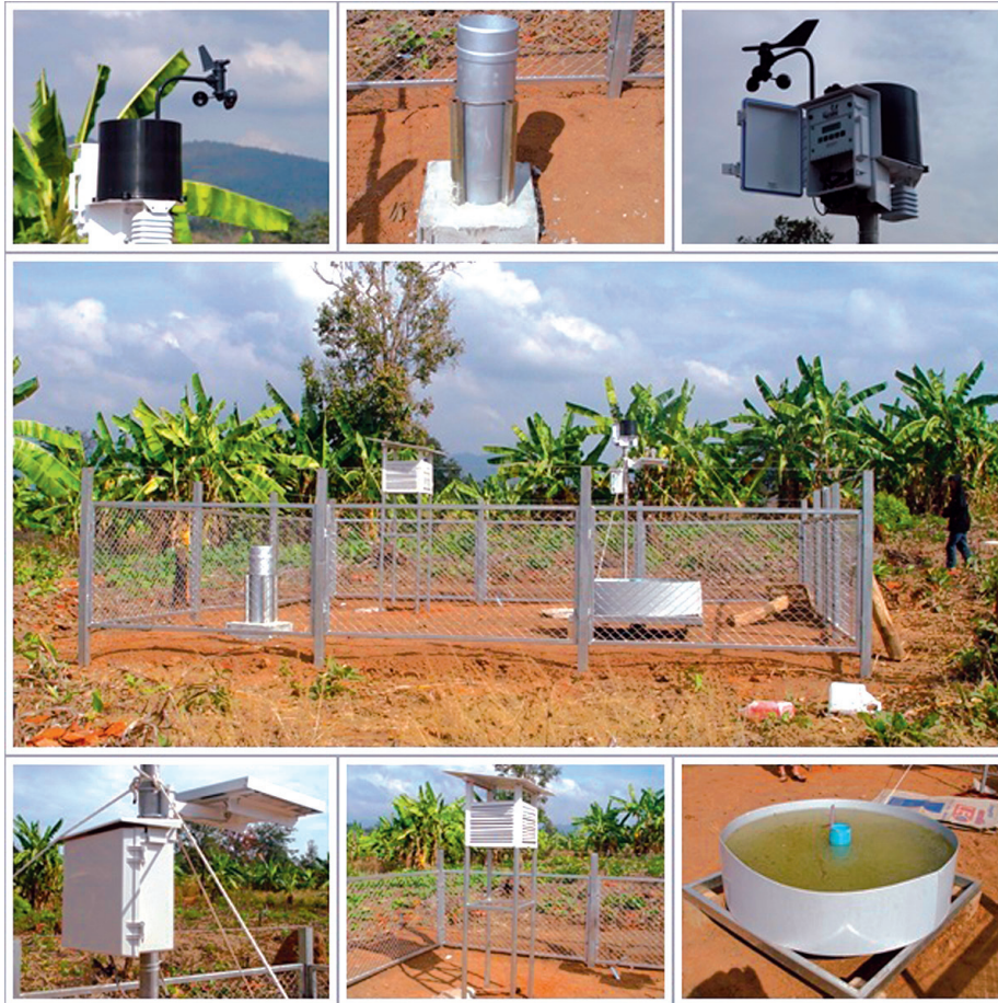
ภาพที่ 3.16 สถานีตรวจวัดอากาศและอุปกรณ์ จากบนซ้ายไปขวา ได้แก่ เครื่องวัดน้ำฝน 1) แบบบันทึก และ 2) แบบตรวจวัด 3) อุปกรณ์อิเล็กทรอนิกส์ 4) สถานีวัดอากาศ 5 x 5 เมตร 5) แผ่นโซลาร์เซลล์ 6) ตู้ติดตั้งเทอร์โมมิเตอร์ วัดอุณหภูมิอากาศ 7) ถาดวัดการระเหยของน้ำ
